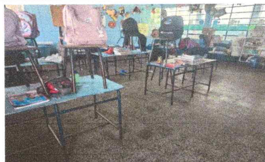
Foto 2: Sustitución de piso de granito por piso cerámico en módulo de aulas, requiere de cambio de piso por deterioro en aula 2
